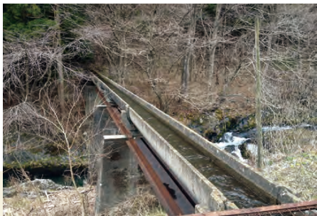
風景に消えていきそうな気仙川に架かる水路橋。コンクリートと鉄だけで出来た美しい造形
