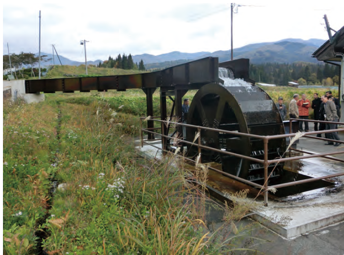
上掛け式水車による水力発電機を設置。他のタイプの水車もあり、水力で地区全住民の電力を賄う(©平野彰秀)
