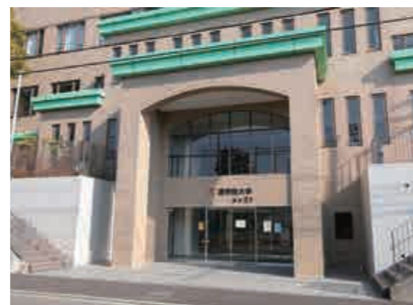
若木21エントランス
