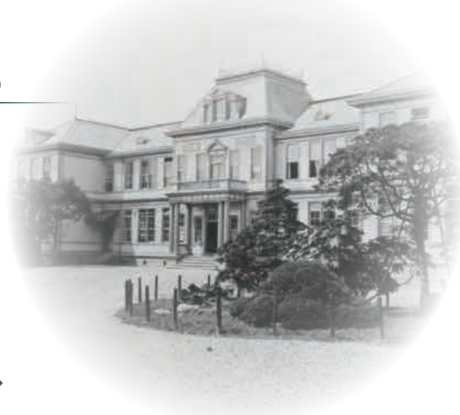
飯田町校舎(明治41年竣工)
