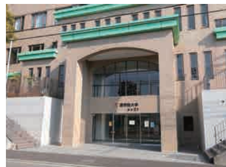
若木21エントランス
